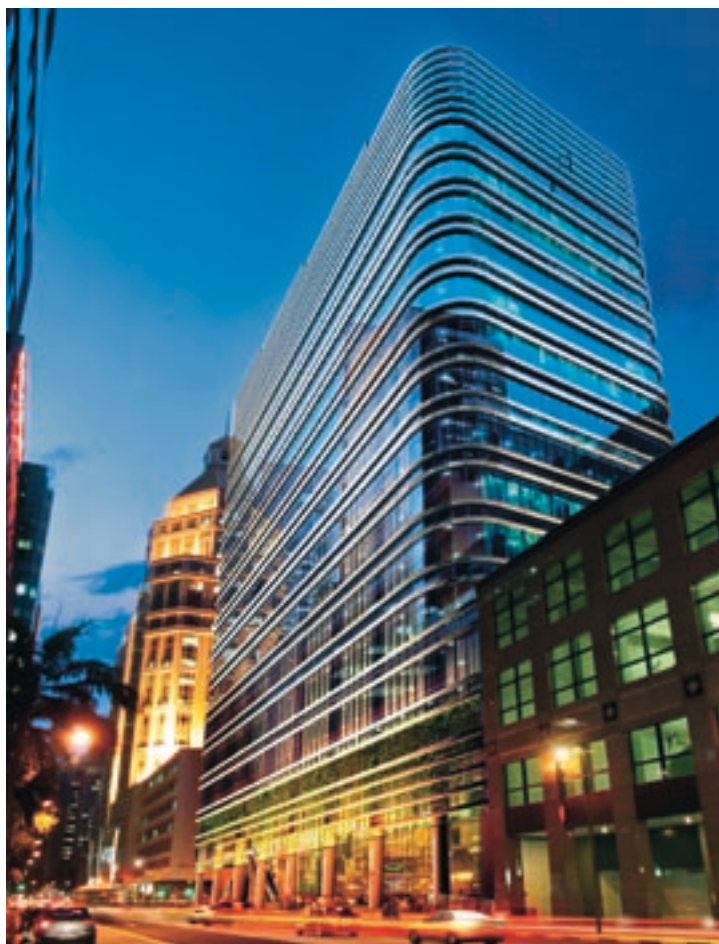
„Robinson Road“ (Büro), Singapur, Immobilie des hausInvest global
